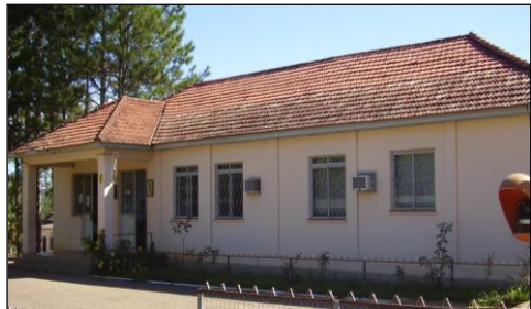
Prédio antes da reforma
